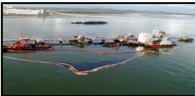
Figura 15: Utilização de barreira de contenção em conjunto com barreiras absorventes no derramamento de óleo do Porto de Paranaguá. Fonte: (Ratton, 2015).
