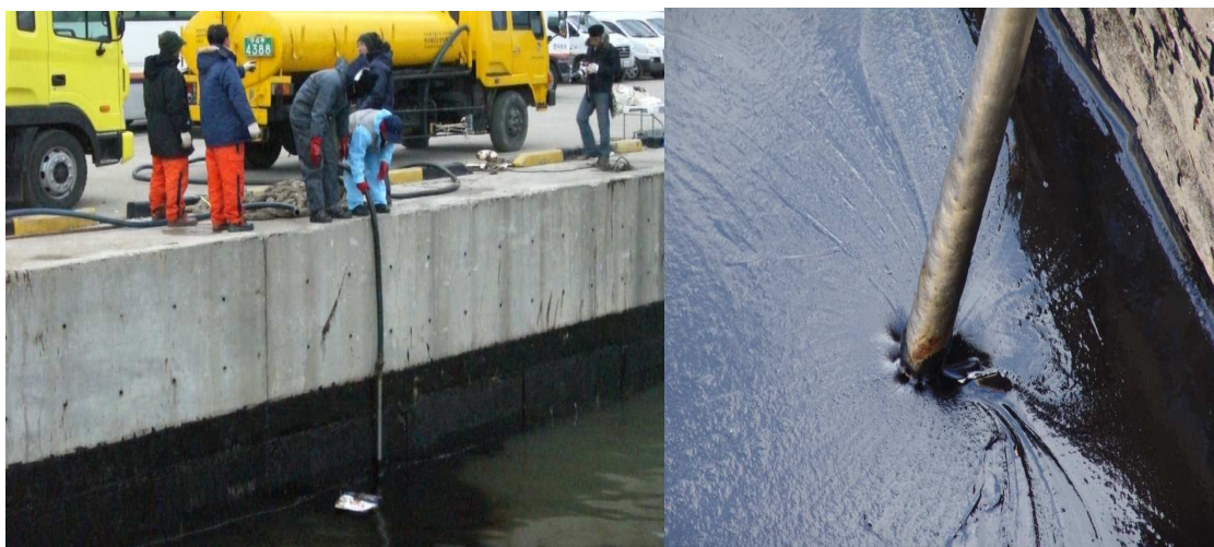
Figura 9: Recolhedor de óleo do tipo vácuo – Heibei Spirit – Coreia do Sul 2007.
