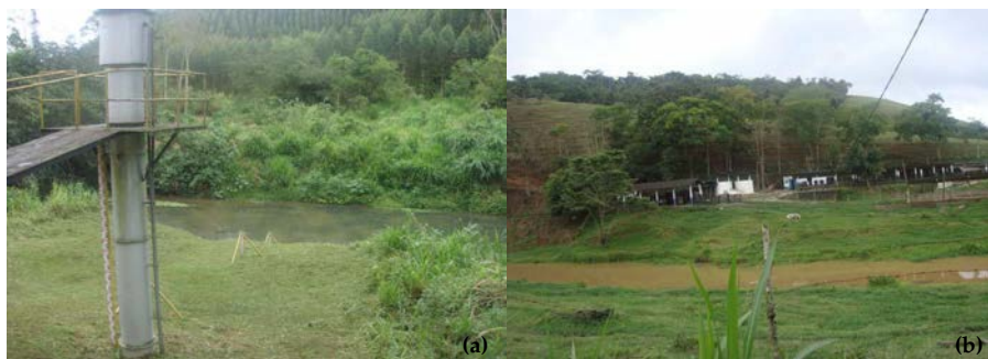
Figura 6.54: Fotos tiradas em 27/11/14 mostrando impacto na CSS no rio Pirai devido a erosão de uma obra na encosta próxima a margem direita: (a) estação 2, logo a montante da obra (7 mg/l) (b) logo a jusante da obra (48 mg/l).
