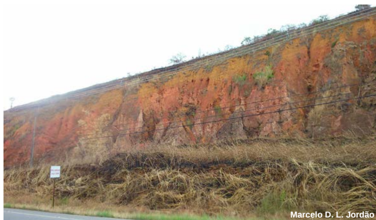
Figura 2.31: Concentração de ravinas degradando um corte da estrada RJ 127 em uma área de pastagens abandonadas, a cerca de 200 m da ponte que cruza o rio Guandu no município de Paracambi - RJ. Foto tirada em 16/06/2015.
