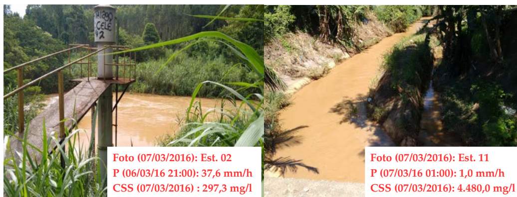
Figura 7.27: Impacto da transposição do rio Pirai no tratamento de água da ETA-Guandu: a foto da esquerda mostra a cheia do rio Pirai após pico de chuva e a foto da direita mostra o lançamento da ETA-Guandu afetado pela transposição da cheia do rio Pirai.
