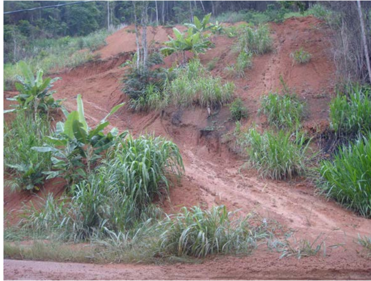
Figura 6.53: Erosão por chuva agindo na obra de corte e terraplanagem de uma encosta às margens direita do rio Pirai, a cerca de 1 km a jusante da estação 2, foto tirada em 27/11/14, as 14 horas, na beira da estrada RJ-145.
