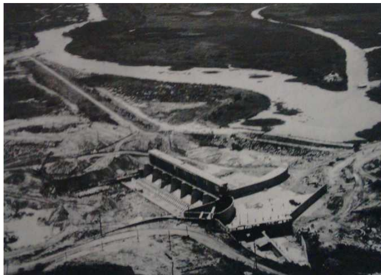
Figura 2.53: Foto sem datação da construção da barragem para captação da ETA-Guandu, concluída em 1965. Foto extraído de RITTA (2009).
