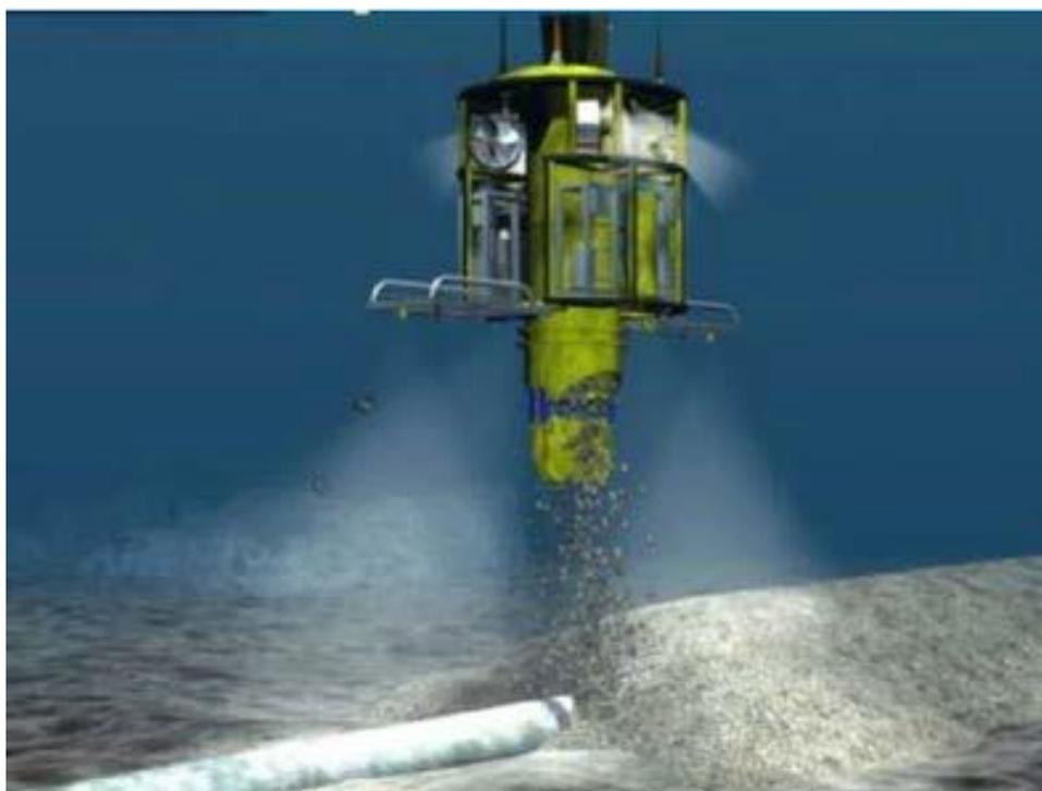
Figura 2-21: Cobrimento de um duto submarino [34].
