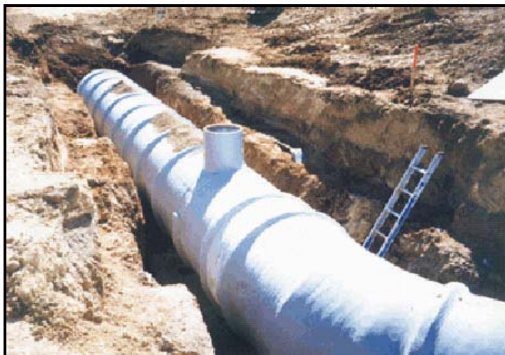
Figura 14: Dutos compósitos em aplicações terrestres.
