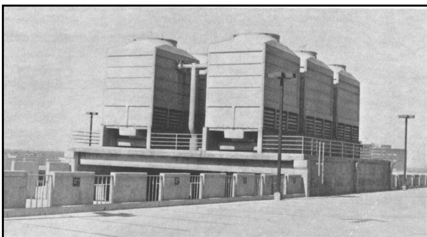
Figura 12: Compósitos aplicados em torres de resfriamento.
