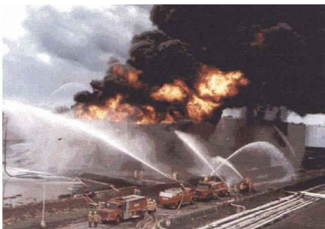
**Figura 2.6** Combate com espumas extintoras do tipo AFFF do maior incêndio ocorrido no Brasil em reservatórios de combustível - Replan, em Janeiro de 1993 (FIGUEREDO & RIBEIRO *et al.*, 1999).
