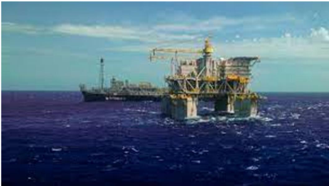
Figura 5.4: ilustração das unidades *offshore* do tipo FPSO e TLWP do caso em estudo
